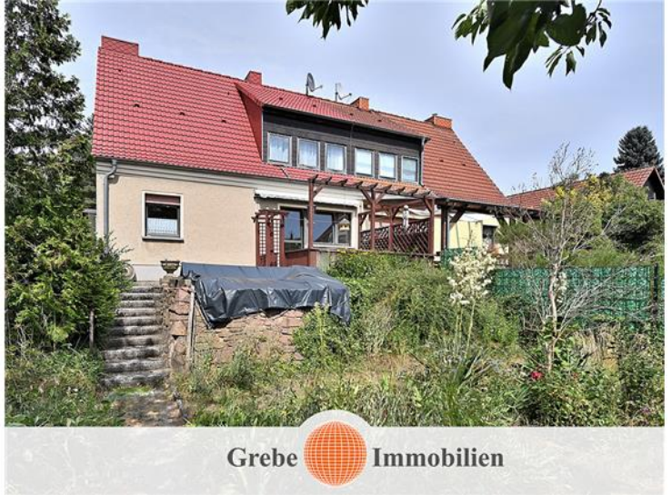
Blick vom unteren Grundstücksbereich
